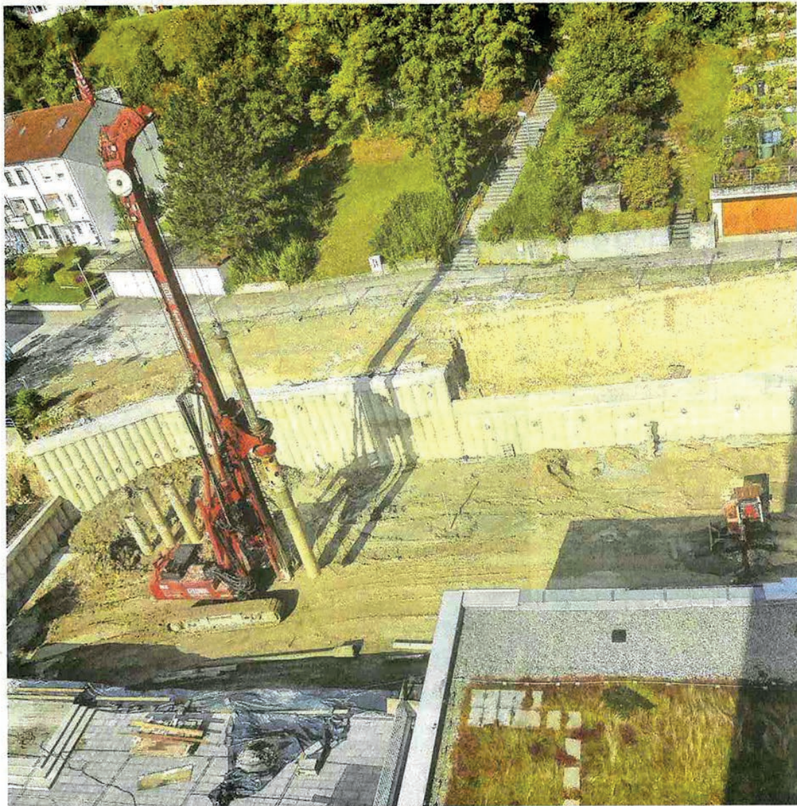
Hier werden die Gründungspfähle für den Hotelneubau in Oberkochen gesetzt. In das Gebäude soll auch ein Restaurant integriert werden. Foto: ls
