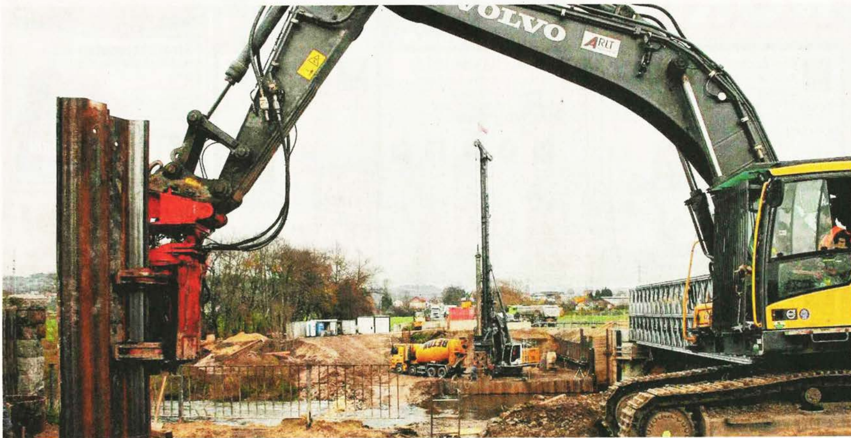
Die Vorbereitungen zur Gründung der neuen Mainbrücke in Hochstadt haben begonnen. Mit Spundwänden werden zurzeit die Uferböschungen befestigt. Am anderen Mainufer bringt eine Spezialfirma die Bohrspfähle für die Widerlager ein. FOTOS: GERHARD HERRMANN
